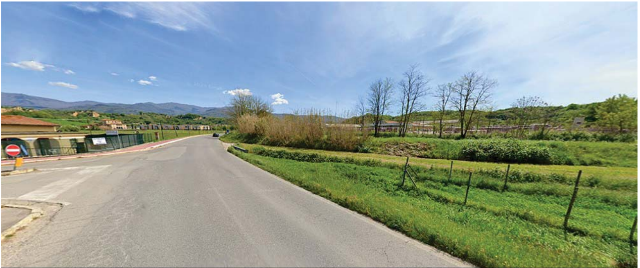
Vista sud-nord – attuale
